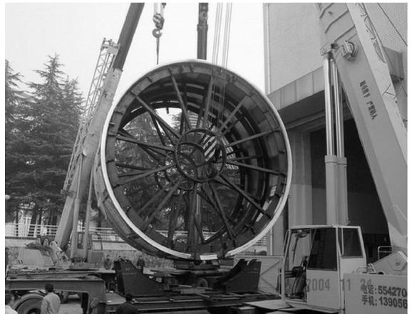
图 11 EAST 装置外真空杜瓦吊装
